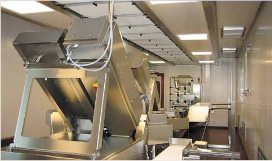
Una camera bianca, locale condizionato per il confezionamento di prodotti alimentari
